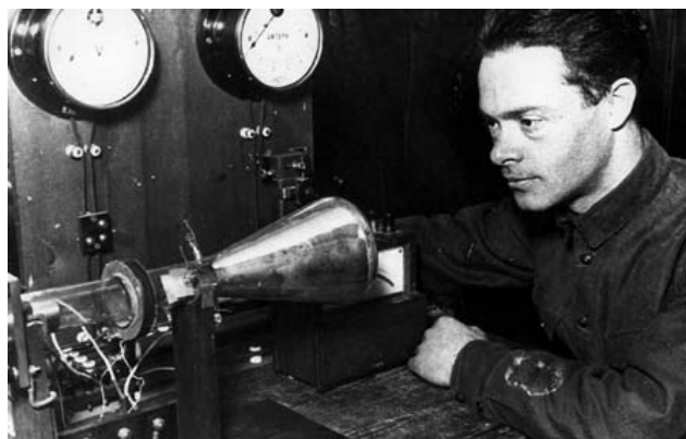
Рис. 3.7. Катодная трубка Томсона для определения удельного заряда электрона
